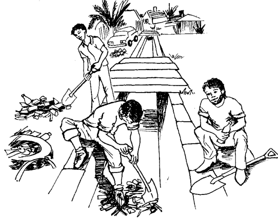
Tahliye kanallarının düzenli olarak temizlenmesi taşkınları ve hastalıkları önlemeye yardım eder.
